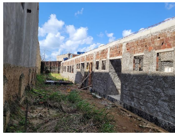
FOTO 2: Vergas e Contravergas;
