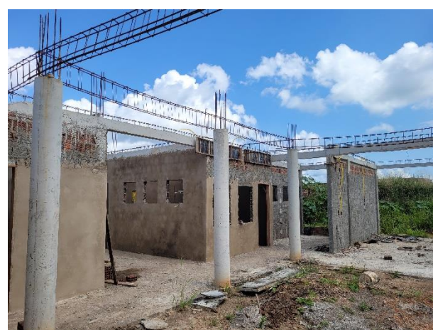
FOTO 6: Posicionamento de armações de vigas;
