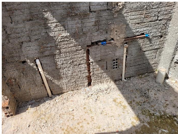
FOTO 19: Pontos hidrossanitários;
