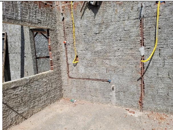
FOTO 22: Pontos hidrossanitários;
