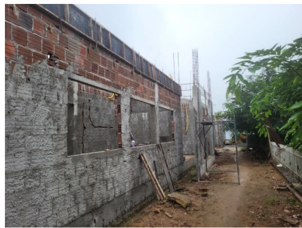
FOTO 1: Vergas e Contravergas;
