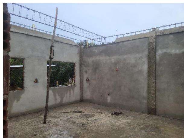
FOTO 4: Posicionamento de armações de vigas;
