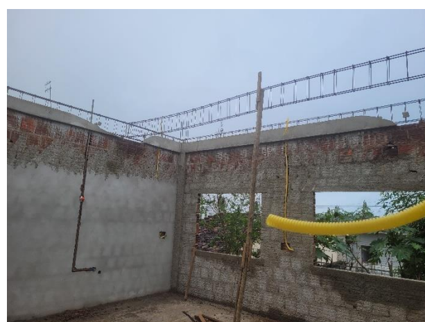
FOTO 5: Posicionamento de armações de vigas;
