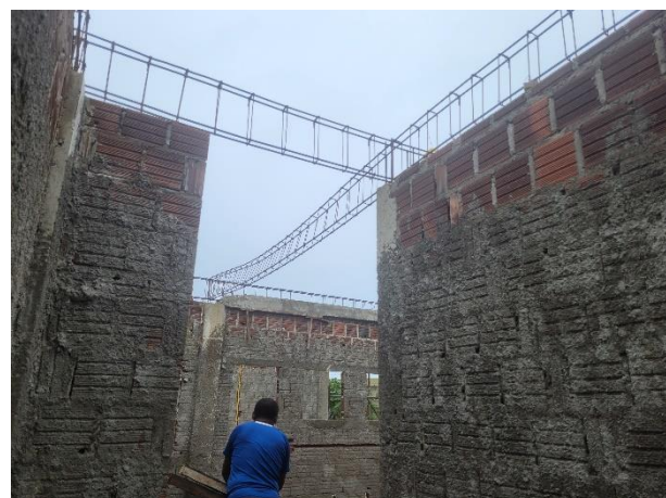
FOTO 3: Posicionamento de armações de vigas;
