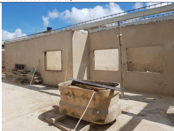
FOTO 13: Vigas concretadas, lastro de concreto e Reboco das Paredes;
