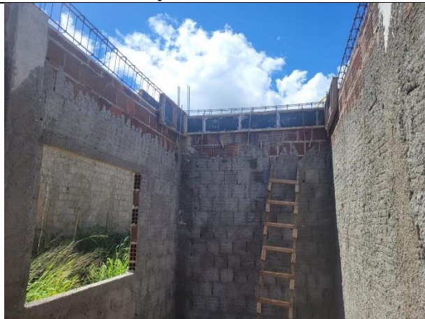
FOTO 7: Posicionamento de armações de vigas e Alvenaria de Vedação;
