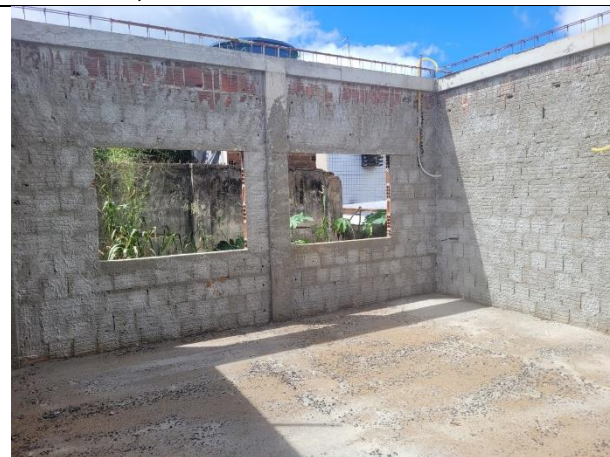
FOTO 10: Concretagem de vigas e Chapisco de ambientes;
