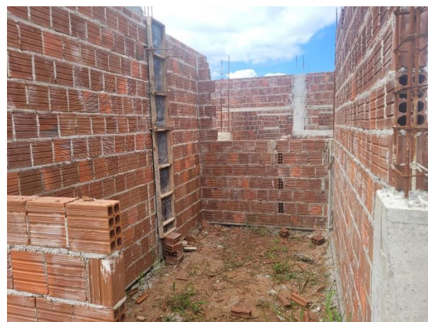
FOTO 5: Concretagem de Pilares, Vergas e Alvenaria de Vedação;
