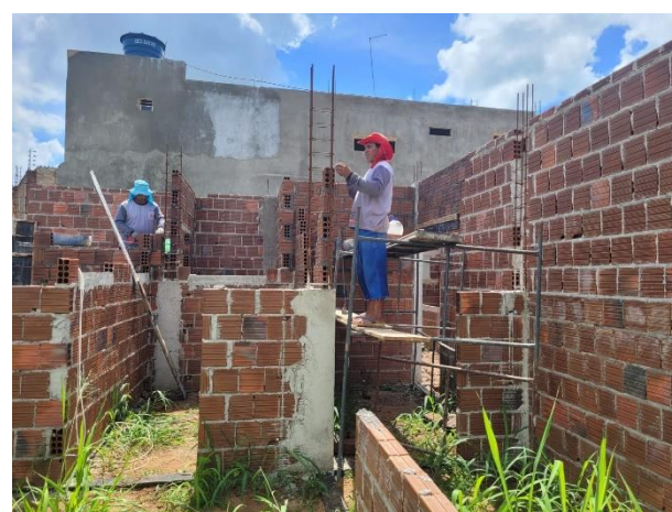
FOTO 2: Posicionamento das armações de pilares;
