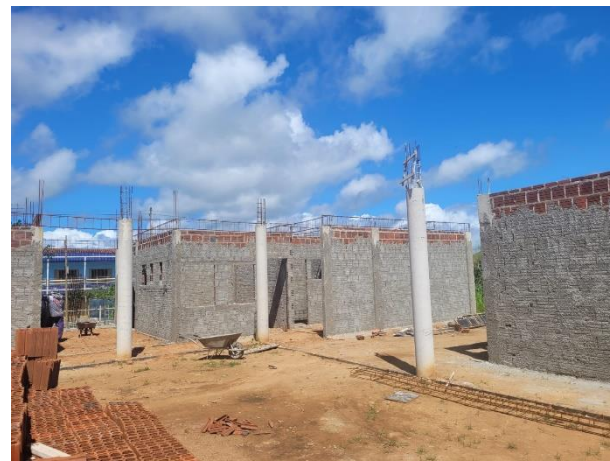
FOTO 8: Posicionamento de armações de vigas e Chapisco;
