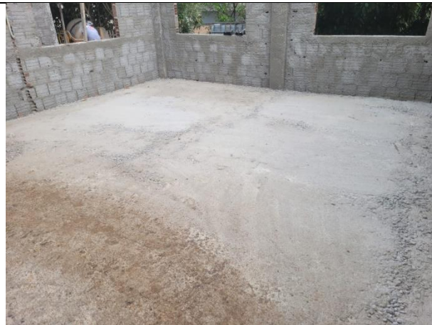
FOTO 16: Lastro de concreto;
