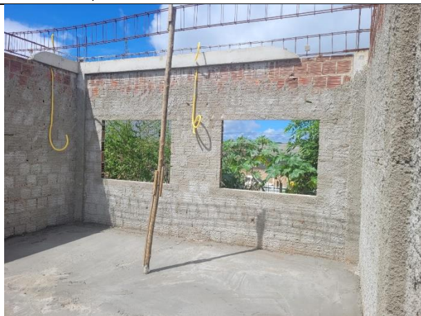
FOTO 9: Concretagem de vigas e Chapisco de ambientes;
