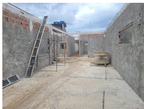
FOTO 13: Lastro de concreto e Chapisco;
