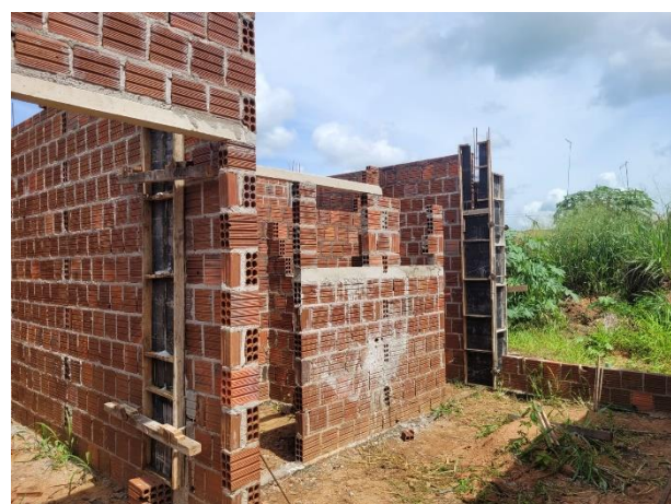
FOTO 3: Concretagem de Pilares, Vergas e Alvenaria de Vedação;
