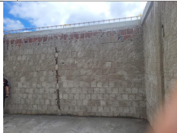
FOTO 8: Posicionamento de armações de vigas e Chapisco;
