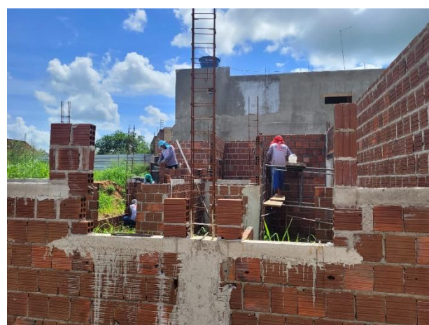
FOTO 1: Vergas e Contravergas;
