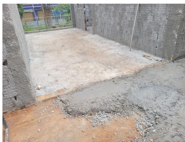
FOTO 14: Lastro de concreto;
