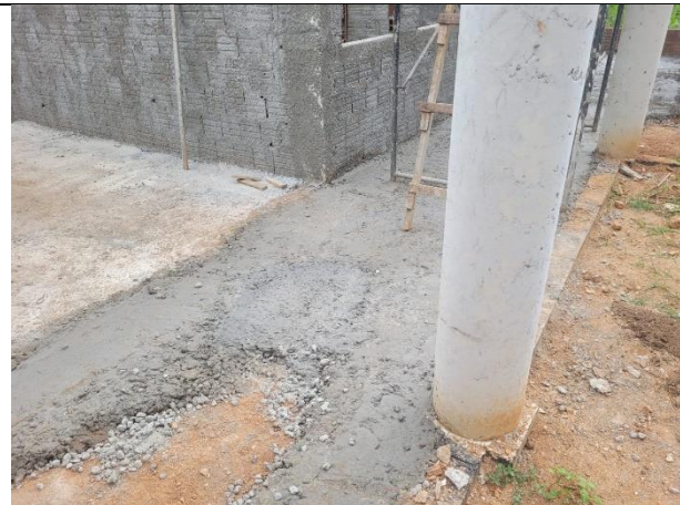
FOTO 15: Lastro de concreto;
