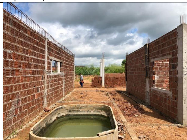
FOTO 13: Alvenaria de vedação, pilares concretados e contravergas e vergas de esquadrias;
