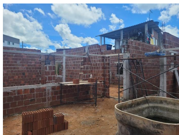
FOTO 7: Alvenaria de vedação, pilares concretados e contravergas e vergas de esquadrias;
