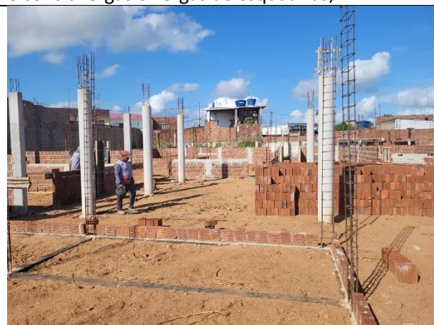
FOTO 7: Alvenaria de vedação, pilares concretados e contravergas e vergas de esquadrias;
