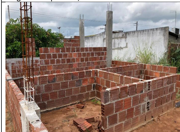
FOTO 21: Alvenaria de vedação e contravergas e vergas de esquadrias;
