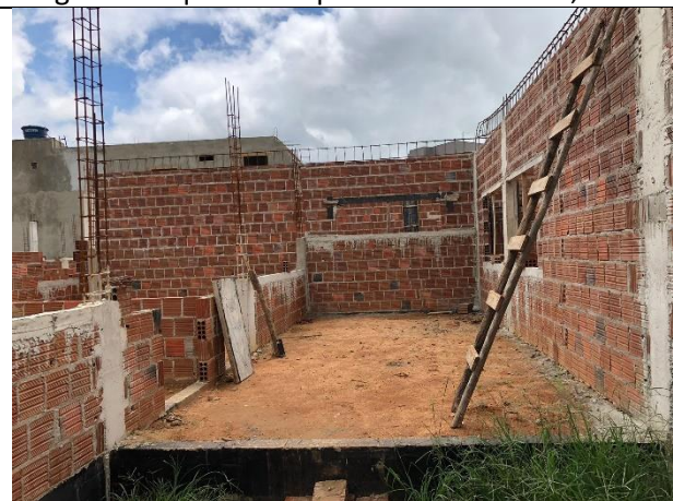
FOTO 22: Alvenaria de vedação, contravergas e vergas de esquadrias e pilares concretados;
