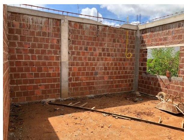
FOTO 13: Alvenaria de vedação, pilares concretados e contravergas e vergas de esquadrias;
