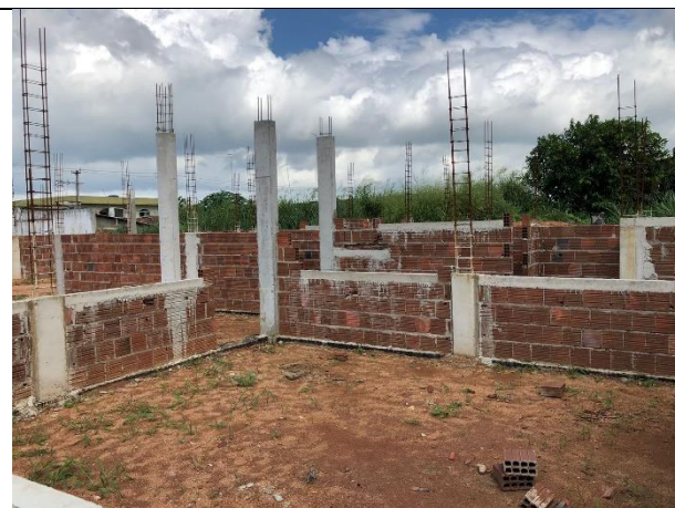
FOTO 18: Alvenaria de vedação e contravergas e vergas de esquadrias ;
