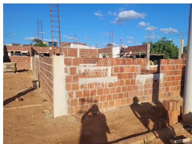
FOTO 3: Alvenaria de vedação e pilares concretados;
