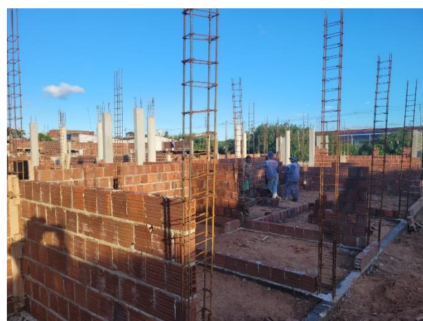
FOTO 1: Posicionamento das armações de pilares;
