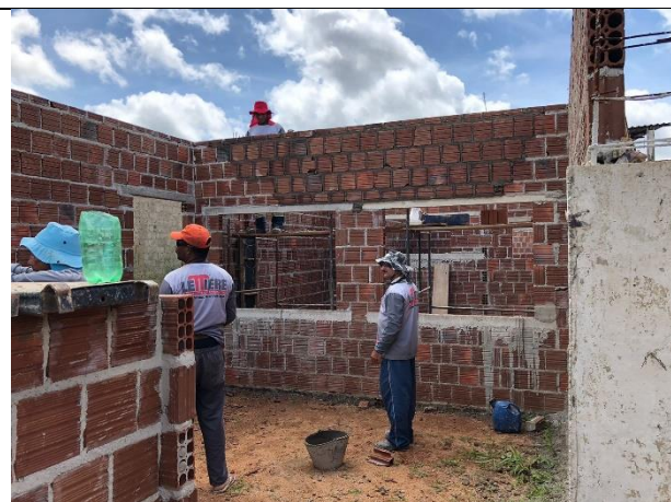
FOTO 15: Alvenaria de vedação e pilares concretados
