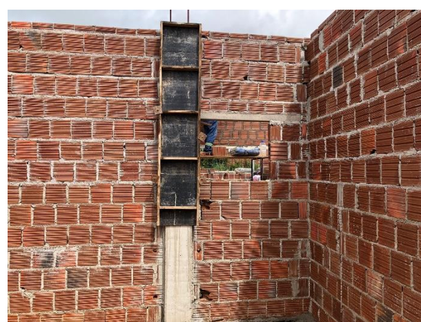
FOTO 14: Forma Para Concretagem de Pilar;
