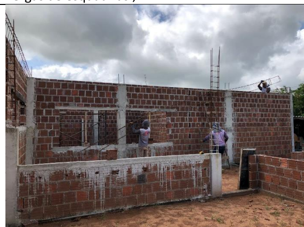
FOTO 20: Alvenaria de vedação e contravergas e vergas de esquadrias ;
