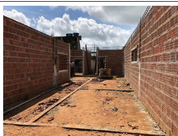
FOTO 20: Alvenaria de vedação e contravergas e vergas de esquadrias ;
