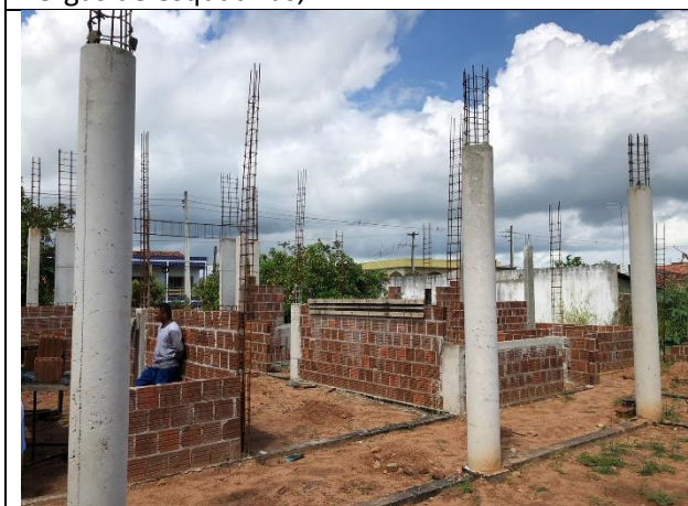
FOTO 19: Alvenaria de vedação e contravergas e vergas de esquadrias;
