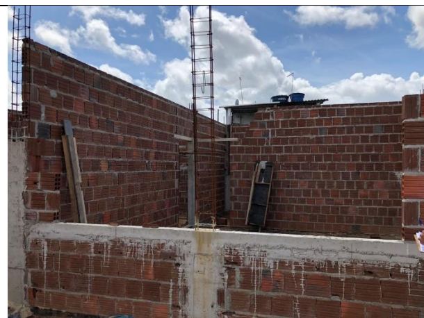
FOTO 16: Contra Verga e Armação de pilar;
