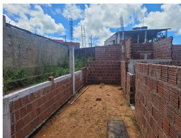
FOTO 8: Vergas e contravergas de esquadrias; ;
