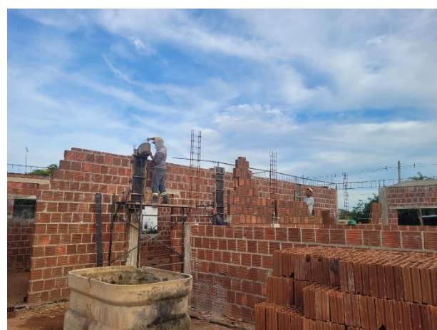
FOTO 5: Alvenaria de vedação;
