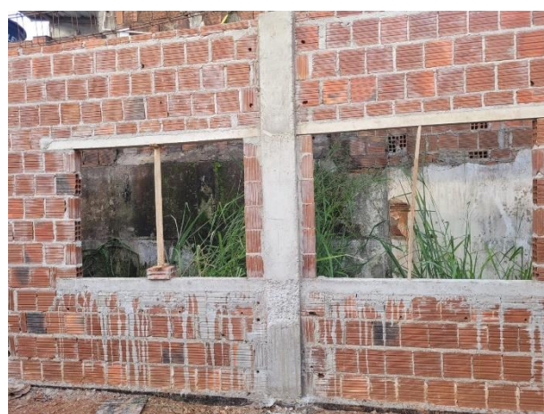
FOTO 6: Vergas e contravergas de esquadrias;
