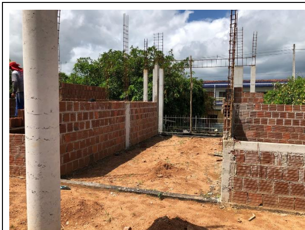
FOTO 19: Alvenaria de vedação e contravergas e vergas de esquadrias;
