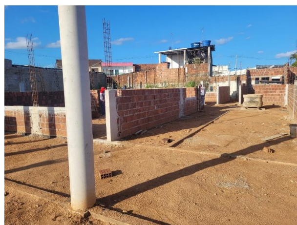
FOTO 4: Alvenaria de vedação e pilares concretados;
