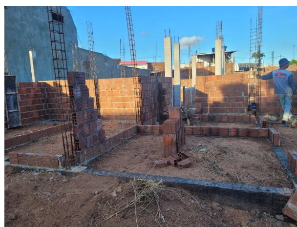
FOTO 2: Posicionamento das armações de pilares;
