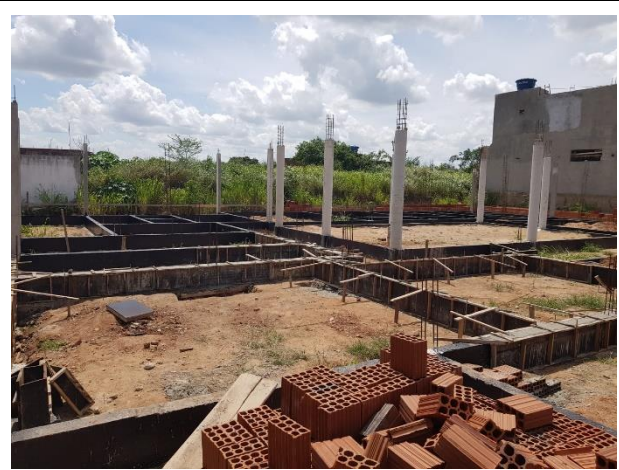
FOTO 14: Montagem das formas para Baldrame;
