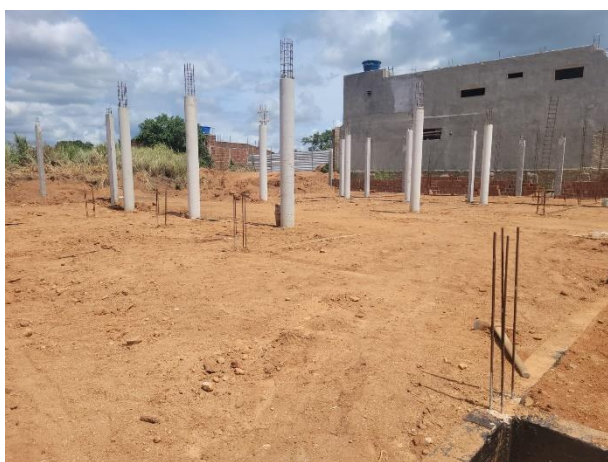
FOTO 23: Estado atual da edificação;
