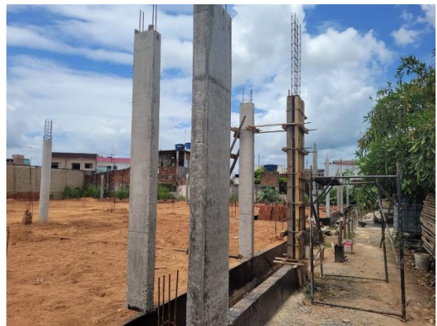
FOTO 22: Pilares concretados;
