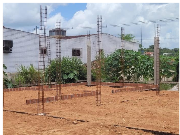
FOTO 20: Armadura para pilares;
