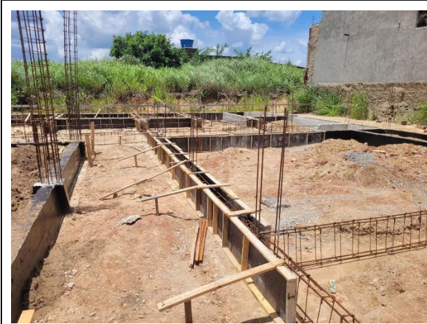
FOTO 13: Montagem das formas para Baldrame;
