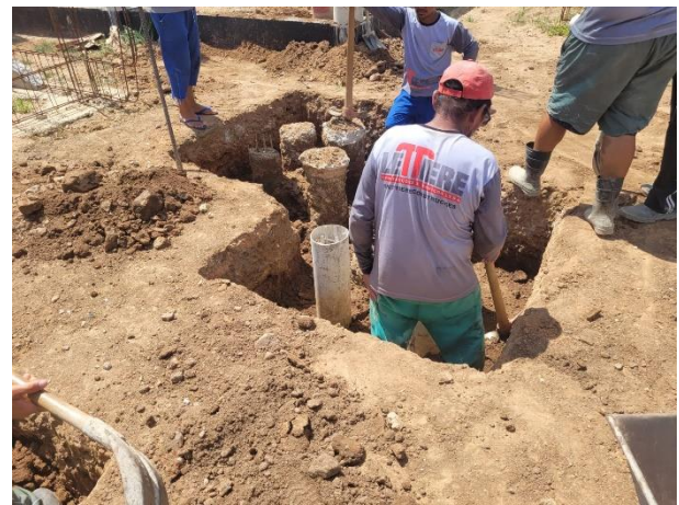
FOTO 4: Escavação Manual de Blocos;
