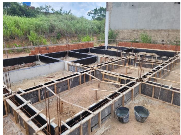
FOTO 12: Montagem das formas para Baldrame;
