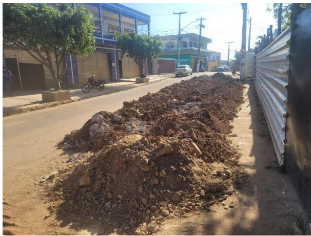
FOTO 1: Retirada de material de escavações;
