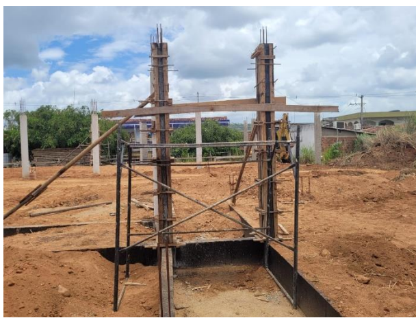
FOTO 19: Montagem das formas para Pilares;
