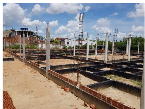
FOTO 18: Impermeabilização de Baldrame;
