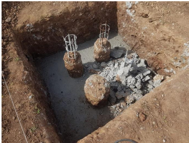
FOTO 9: Lastro de concreto magro e arrasamento das estacas;
