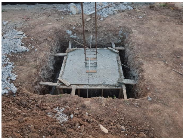
FOTO 11: Concretagem dos Blocos;
