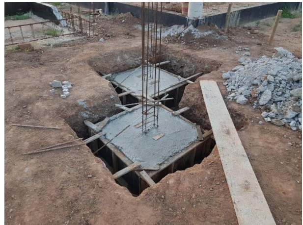
FOTO 10: Concretagem dos Blocos;
