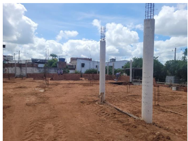
FOTO 24: Estado atual da edificação;
