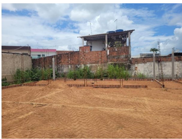
FOTO 7: Aterro das baldrame;
