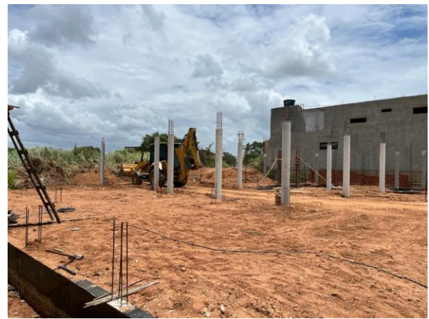
FOTO 2: Transporte de aterro com maquinário;
