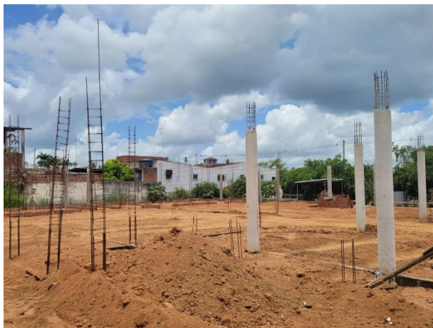
FOTO 21: Pilares concretados;
