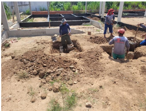
FOTO 3: Escavação Manual de Blocos;
