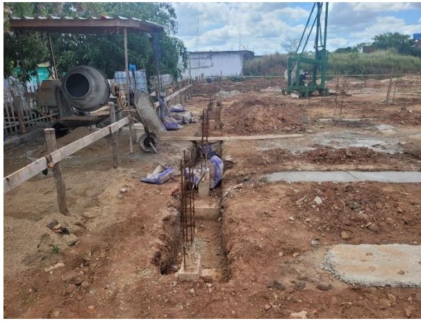
FOTO 1: Escavação Manual para embasamento de alvenaria de 1 vez;
