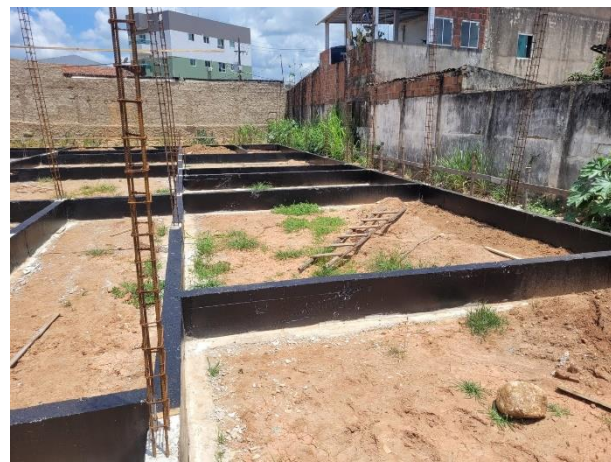
FOTO 9: Vigas baldrames concretadas e impermeabilizadas;
