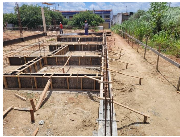
FOTO 7: Colocação das armações e montagem das formas para viga baldrame;
