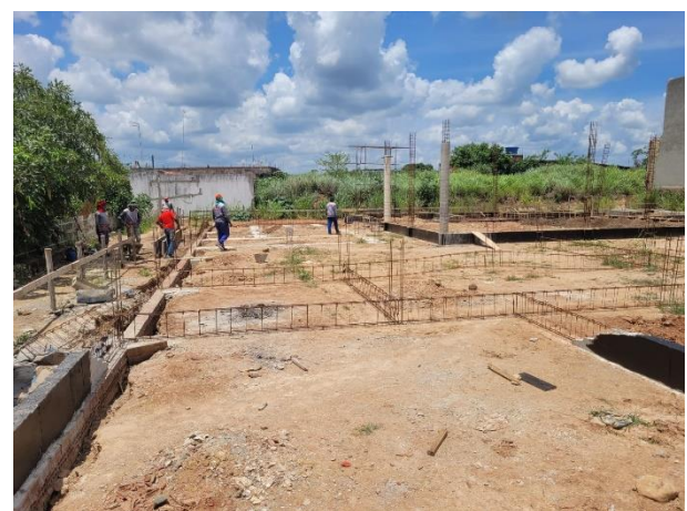
FOTO 12: Fase da obra na medição;
