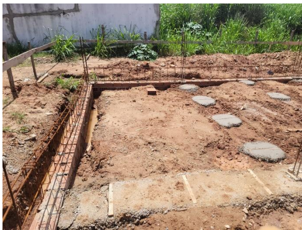
FOTO 3: Embasamento de alvenaria de 1 vez;
