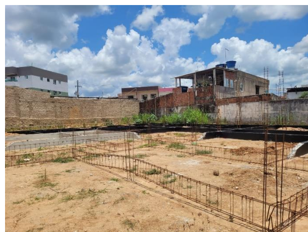
FOTO 11: Fase da obra na medição;
