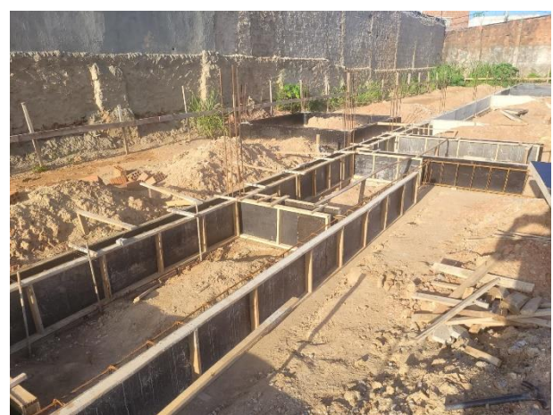
FOTO 6: Colocação das armações e montagem das formas para viga baldrame;
