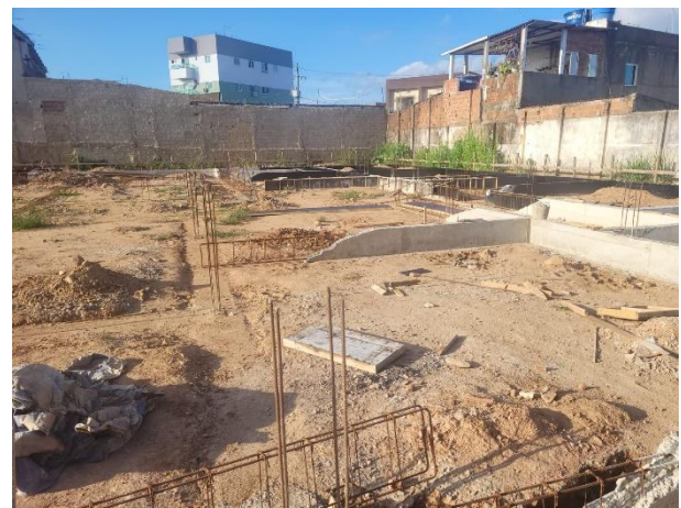
FOTO 4: Lastro de concreto magro;
