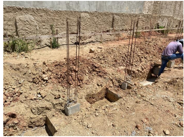
FOTO 2: Escavação Manual para embasamento de alvenaria de 1 vez;
