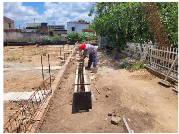
FOTO 8: Colocação das armações e montagem das formas para viga baldrame;
