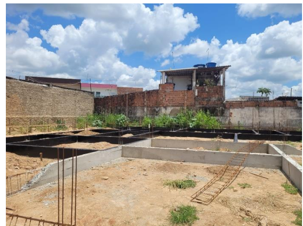
FOTO 10: Vigas baldrames concretadas e impermeabilizadas;
