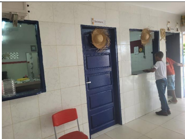
FOTO 17: Pintura de Esquadrias e Gradis;
