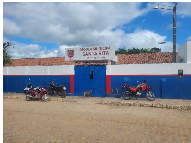
FOTO 19: Pintura do Muro;
