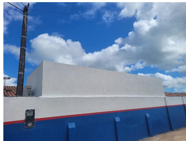
FOTO 20: Pintura do Muro;
