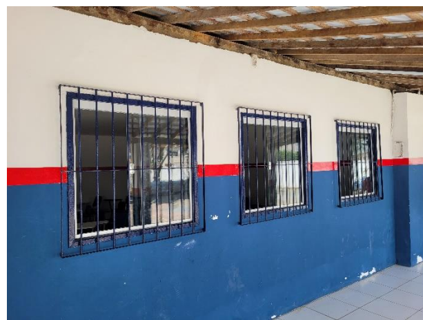
FOTO 5: Janelas de vidro temperado instaladas;
