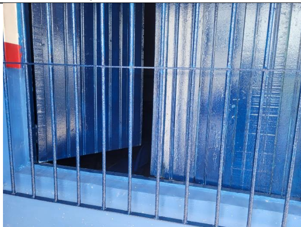
FOTO 11: Pintura de Esquadrias e Gradis;
