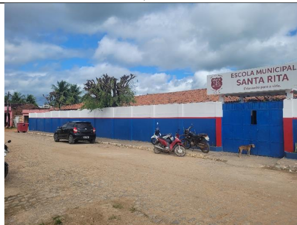
FOTO 18: Pintura do Muro;
