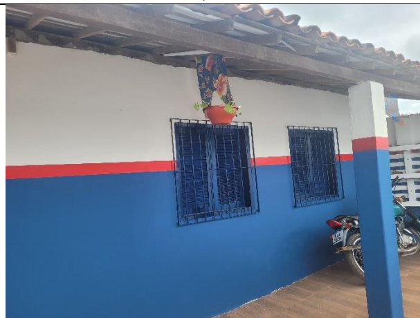
FOTO 12: Pintura de Esquadrias e Gradis;
