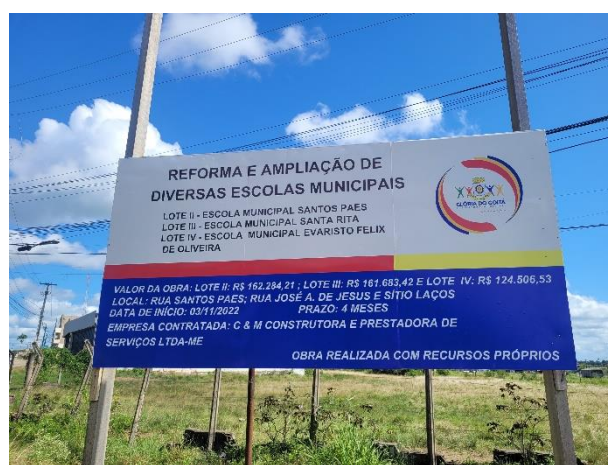
FOTO 2: Placa de Obra Instalada;
