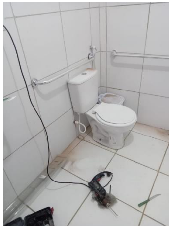
FOTO 7: Barras de apoio instaladas;
