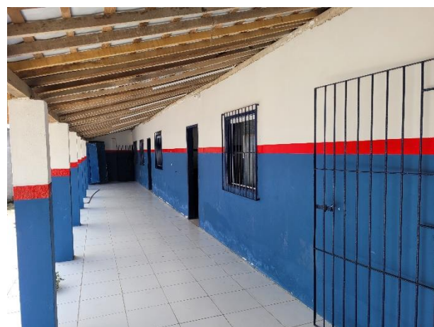
FOTO 3: Revestimento Cerâmico dos Pisos da Calçada Posterior;
