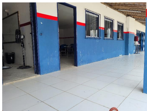
FOTO 4: Revestimento Cerâmico dos Pisos da Calçada Posterior;
