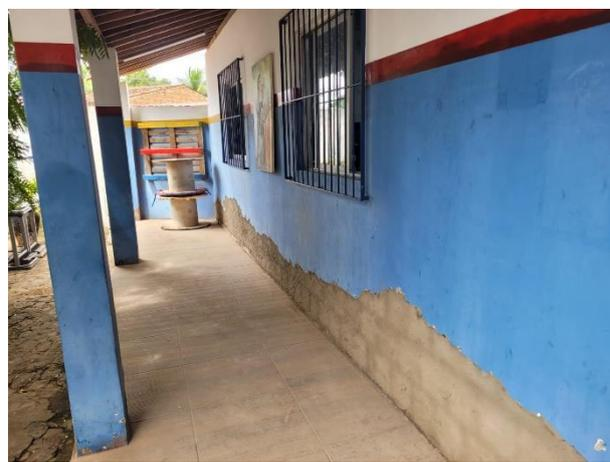
FOTO 2: Reparo com reboco de paredes;
