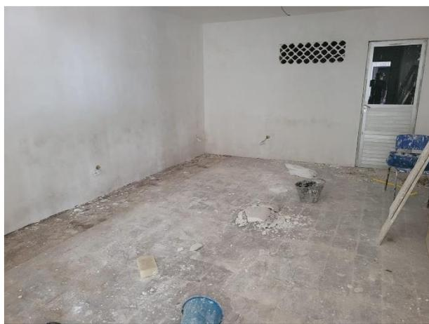
FOTO 1: Demolição de piso cerâmico;
