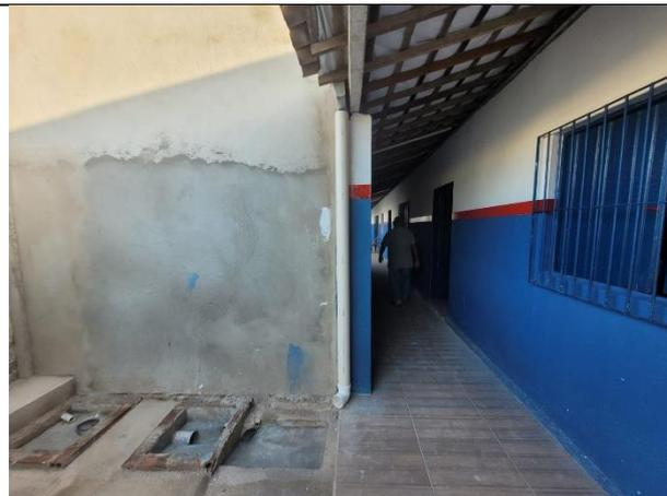
FOTO 22: Tubo de descida de água pluvial;
