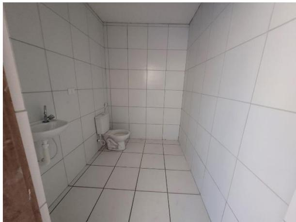
FOTO 7: Revestimento Cerâmico em paredes;
