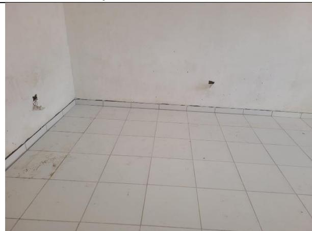
FOTO 18: Revestimento cerâmico de piso;
