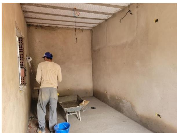
FOTO 5: Massa única/Emboço da Ampliação;
