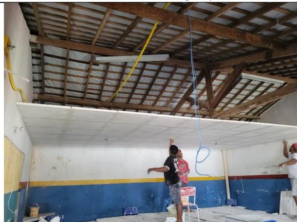
FOTO 24: Instalação de forro de gesso;
