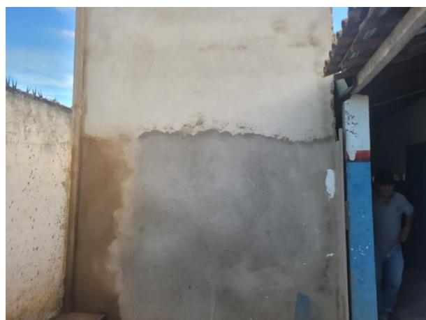
FOTO 6: Massa única/Emboço da Ampliação;
