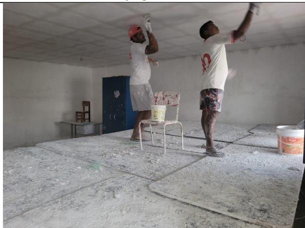
FOTO 23: Instalação de forro de gesso;
