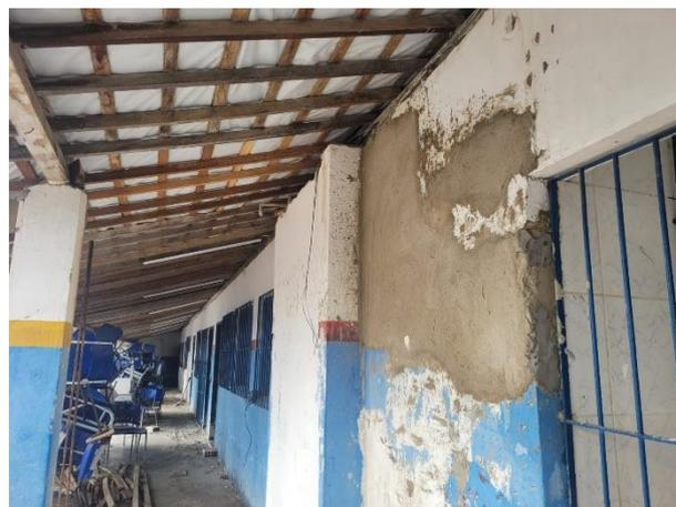
FOTO 4: Reparo com reboco de paredes;
