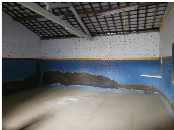
FOTO 3: Reparo com reboco de paredes;
