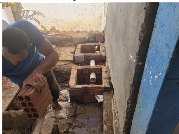
FOTO 28: Caixas enterradas para drenagem;
