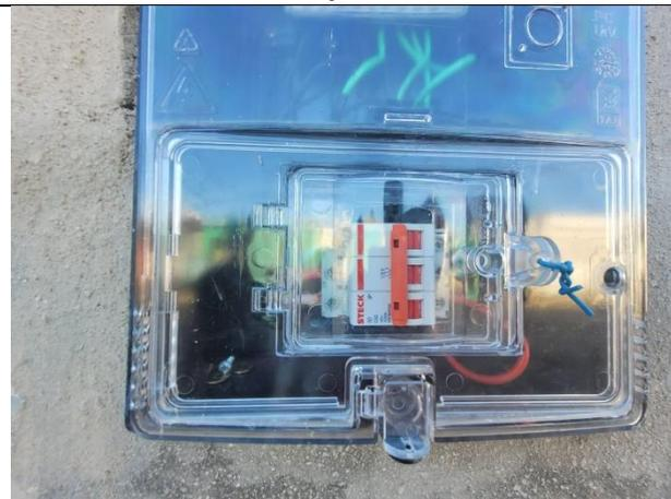
FOTO 41: Disjuntor da caixa de medição;
