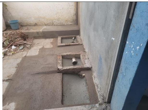
FOTO 27: Caixas enterradas para drenagem;
