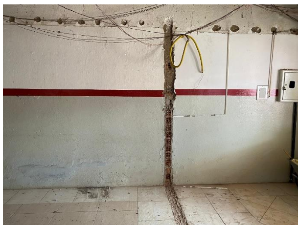
FOTO 1: Demolição de alvenaria;
