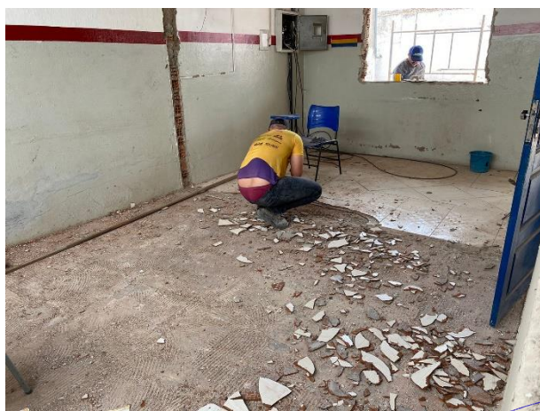
FOTO 5: Demolição de piso cerâmico;
