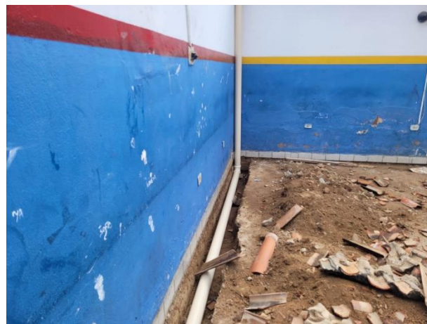
FOTO 26: Instalação de tubos de descidas;
