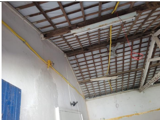
FOTO 21: Novas instalações elétricas;
