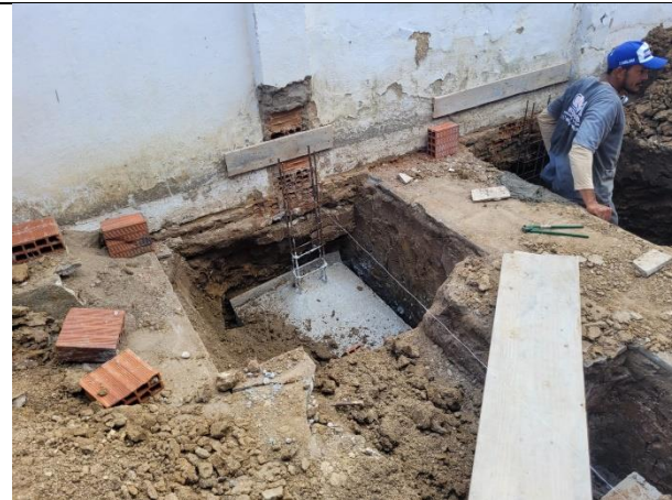
FOTO 8: Lastro de concreto e armações da sapata;
