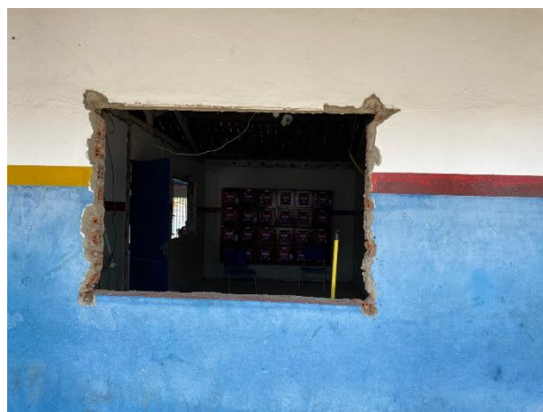
FOTO 2: Demolição de alvenaria;
