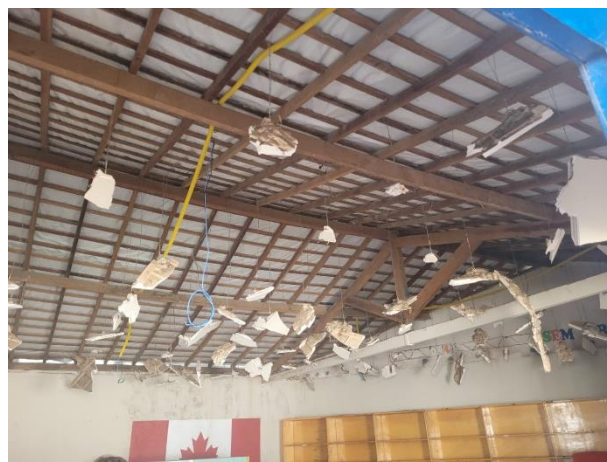
FOTO 4: Remoção de forro PVC/Gesso;
