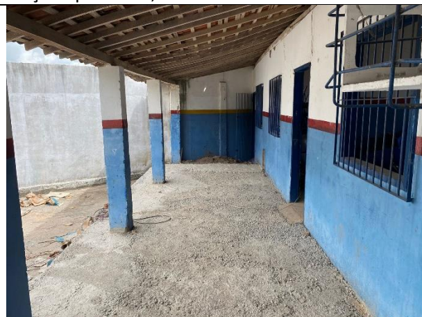
FOTO 28: Alvenaria de 1 vez – Nivelamento da Calçada posterior;
