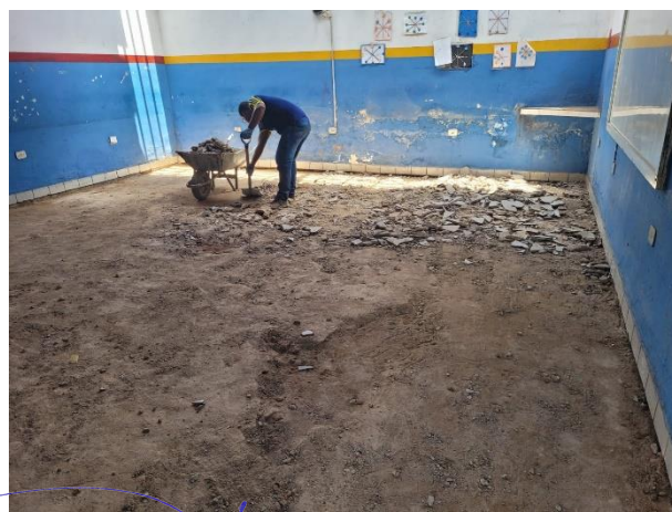
FOTO 6: Demolição de piso cerâmico;
