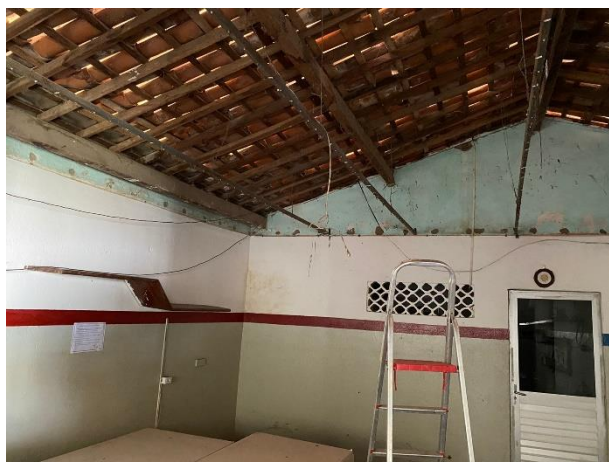
FOTO 3: Remoção de forro PVC/Gesso;
