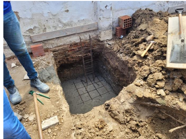
FOTO 8: Lastro de concreto e armações da sapata;
