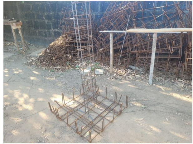
FOTO 10: Armações para bloco e pilares;
