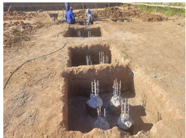
FOTO 6: Arrasamento de estacas;
