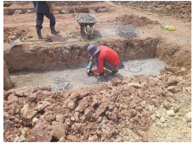
FOTO 8: Arrasamento de estacas e concreto magro do Bloco;
