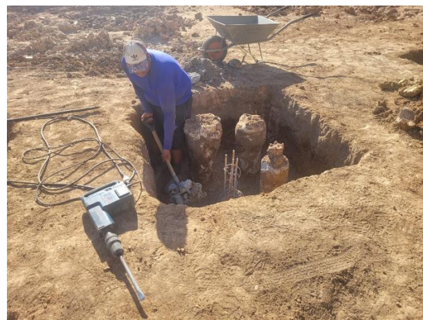
FOTO 5: Arrasamento de estacas;
