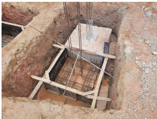
FOTO 15: Blocos de coroamento;
