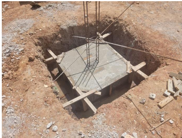
FOTO 13: Concretagem dos Blocos de coroamento;
