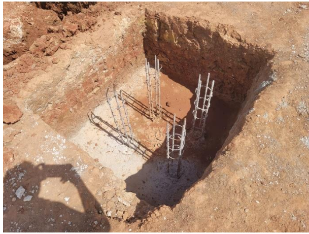
FOTO 7: Arrasamento de estacas e concreto magro do Bloco;
