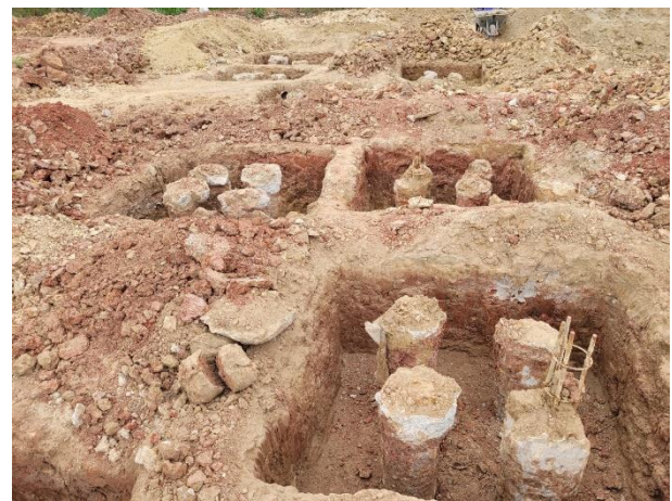
FOTO 4: Escavação Manual para o bloco de coroamento;
