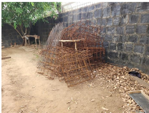
FOTO 11: Armações para bloco e pilares;
