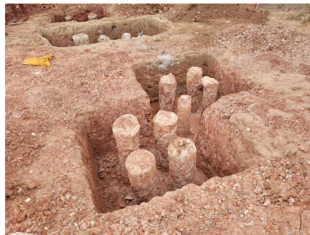
FOTO 3: Escavação Manual para o bloco de coroamento;
