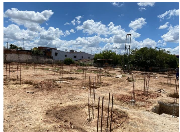
FOTO 18: Pescoço de pilar e bloco de coroamento concretado;
