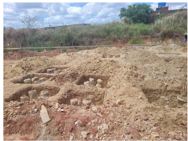
FOTO 2: Escavação Manual para o bloco de coroamento;
