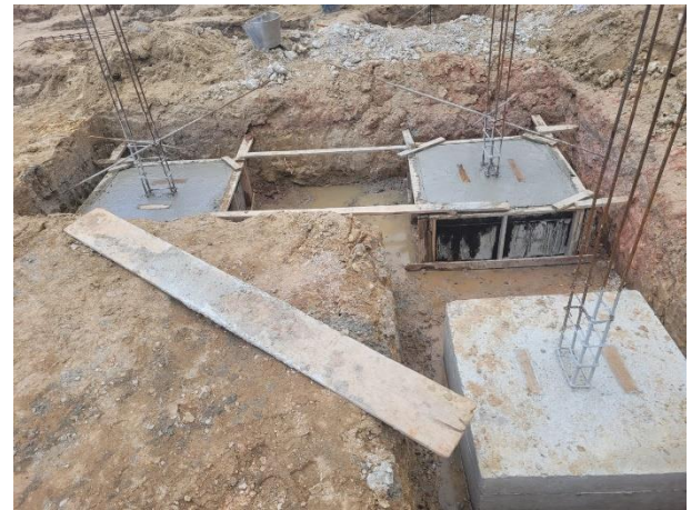
FOTO 14: Blocos de coroamento;
