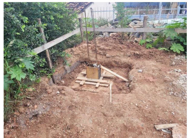
FOTO 16: Formas para pescoços dos pilares;
