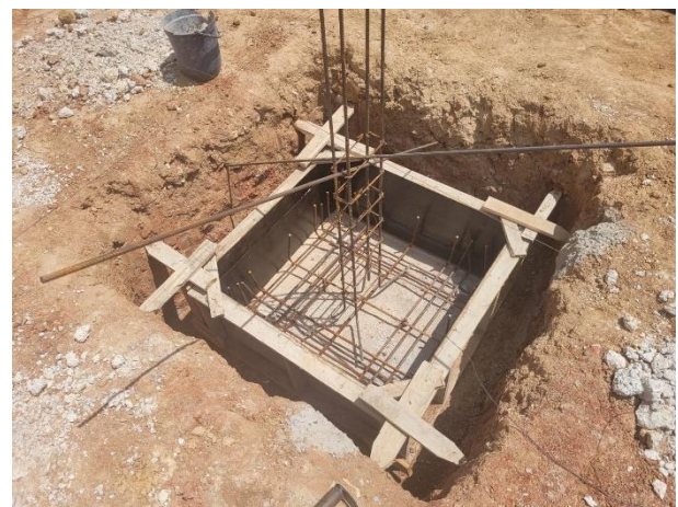
FOTO 12: Armadura e formas posicionadas para concretagem dos blocos;
