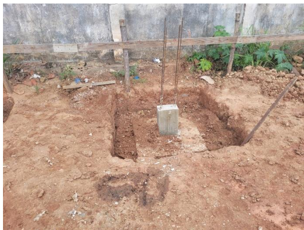
FOTO 17: Pescoço de pilar e bloco de coroamento concretado;
