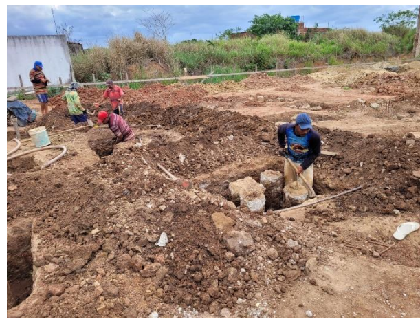
FOTO 1: Escavação Manual para o bloco de coroamento;
