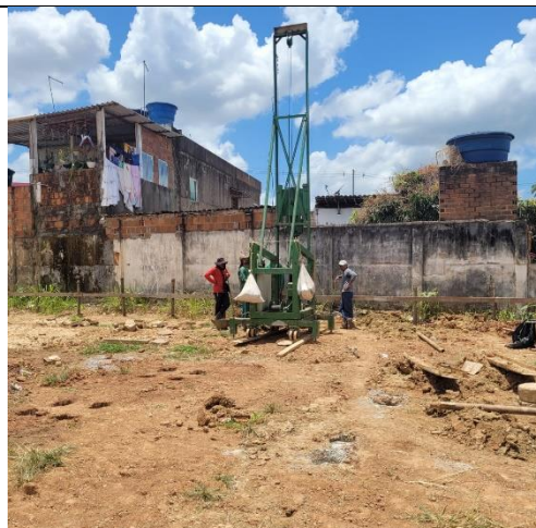
FOTO 4: Escavação de furo com perfuratriz hidráulica;
