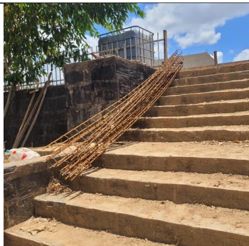
FOTO 2: Armaduras montadas;
