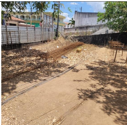
FOTO 1: Armaduras montadas;
