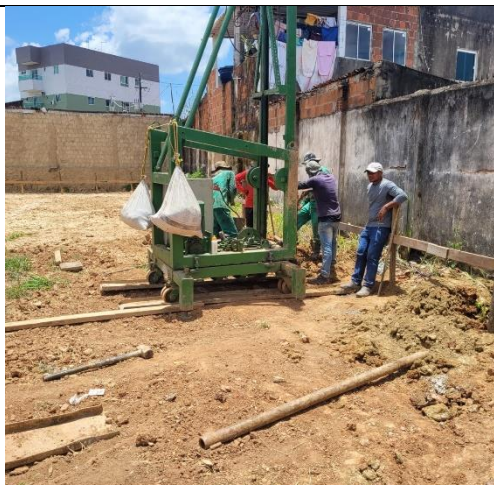
FOTO 3: Escavação de furo com perfuratriz hidráulica;
