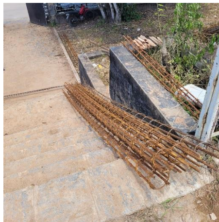
FOTO 2: Armaduras montadas;
