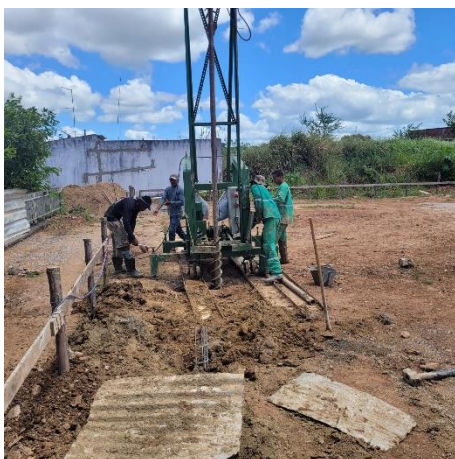
FOTO 3: Escavação de furo com perfuratriz hidráulica;
