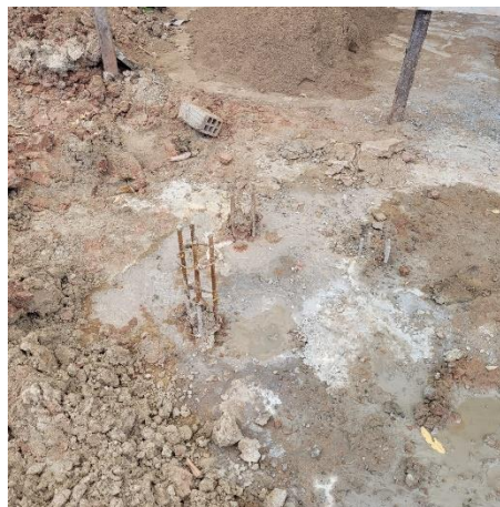
FOTO 6: Estacas finalizadas;
