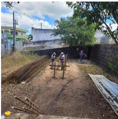
FOTO 1: Montagem das armações;
