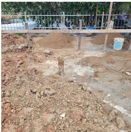
FOTO 5: Estacas finalizadas;
