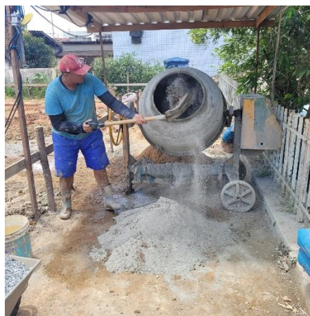
FOTO 4: Produção de concreto com betoneira;
