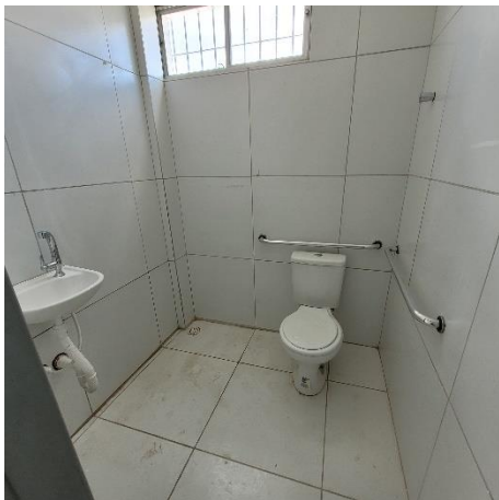
FOTO 13: Louças e barras instaladas;
