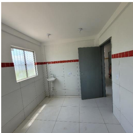
FOTO 15: Louças e portas instaladas;
