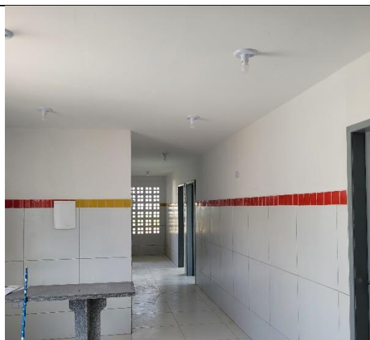
FOTO 8: Revestimento cerâmico interno;
