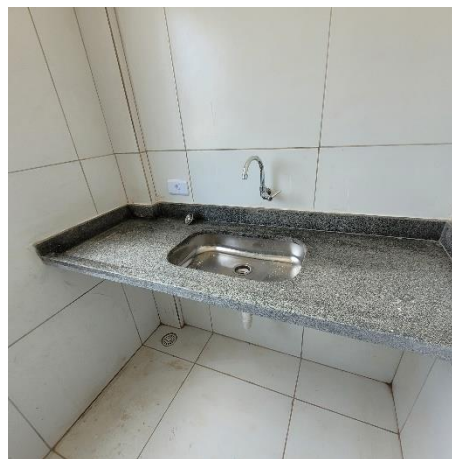
FOTO 18: Pia, ralos e conexões executadas ;
