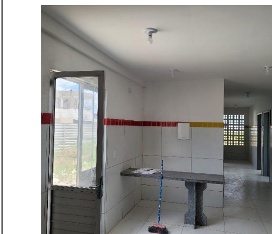
FOTO 9: Bancada de granito instalada;
