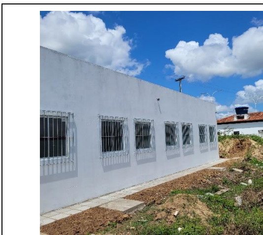
FOTO 7: Grades de proteção instaladas;
