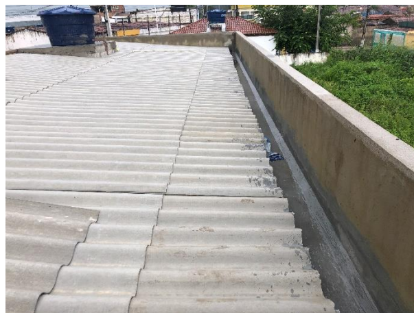
FOTO 8: Telhamento em telha fibrocimento e calha impermeabilizada;
