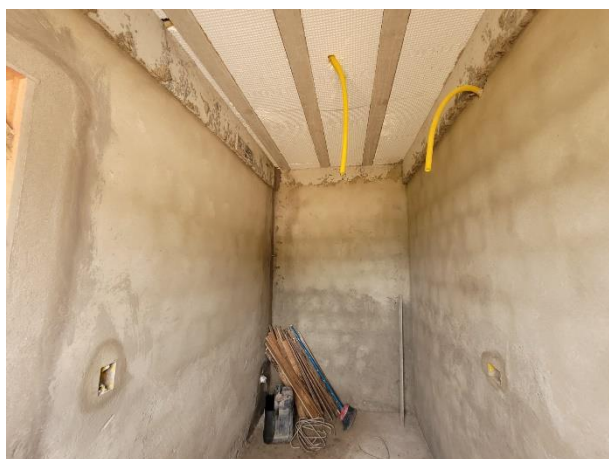
FOTO 9: Execução de instalações elétricas;
