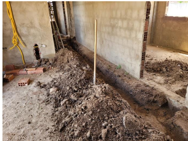
FOTO 14: Execução de instalações hidrossanitárias;
