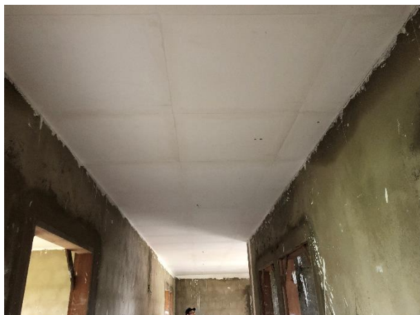
FOTO 7: Forro de gesso executado;
