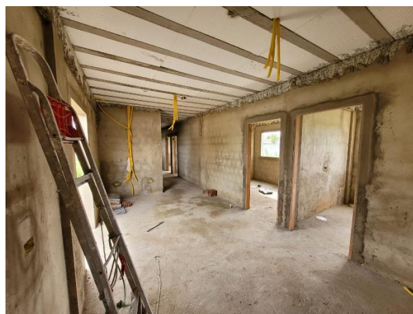
FOTO 10: Execução de instalações elétricas;
