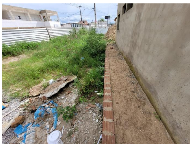
FOTO 1: Execução de calçada no perímetro;
