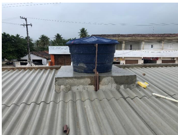
FOTO 3: Caixa de água instalada;
