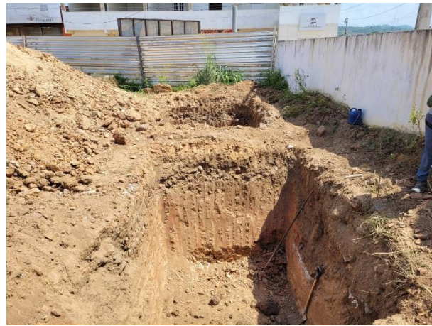
FOTO 20: Escavação para fossa e sumidouro;
