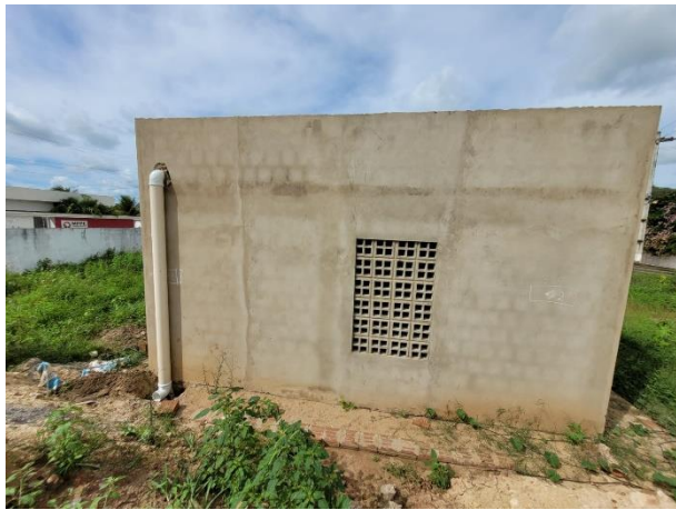
FOTO 19: Descida de água da cobertura;
