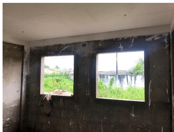
FOTO 6: Forro de gesso executado;
