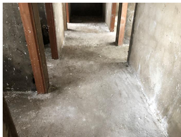
FOTO 4: Lastro e contrapiso executados;
