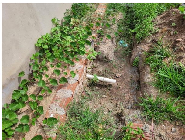
FOTO 17: Execução caixa enterrada;
