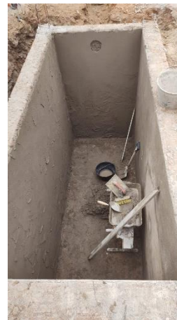
FOTO 22: Execução de fossa e sumidouro;
