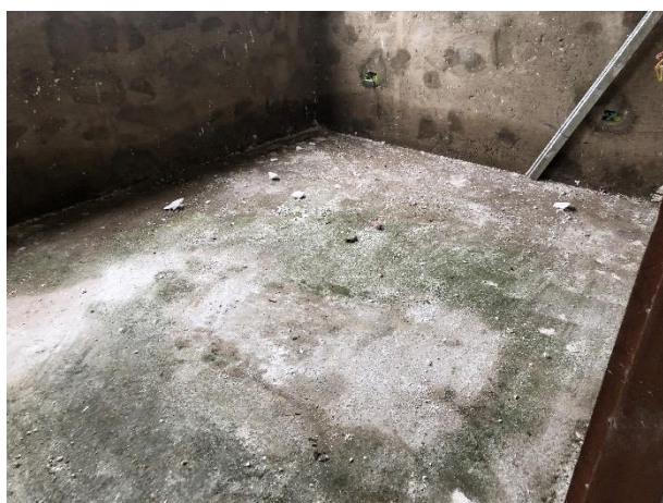
FOTO 5: Lastro e contrapiso executados;
