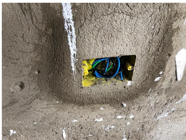
FOTO 11: Execução de instalações elétricas;
