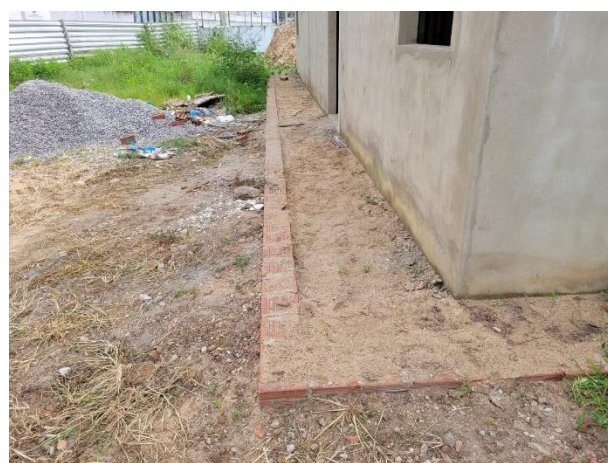
FOTO 2: Execução de calçada no perímetro;
