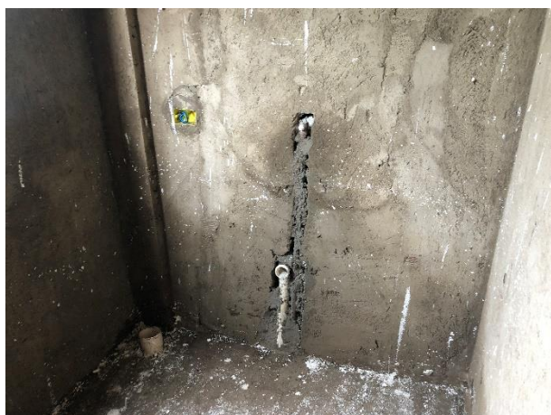
FOTO 15: Execução de instalações hidrossanitárias;
