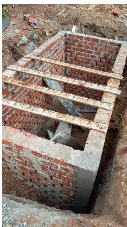
FOTO 23: Execução caixa enterrada;
