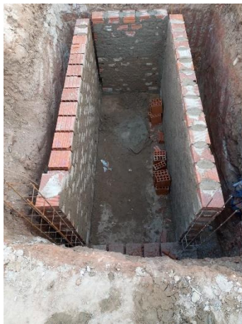
FOTO 21: Execução de fossa e sumidouro;
