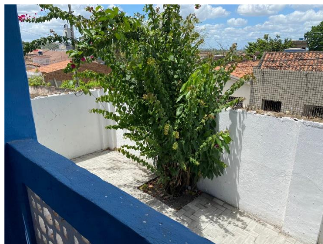
Foto 12: Pintura da parede externa executada.
