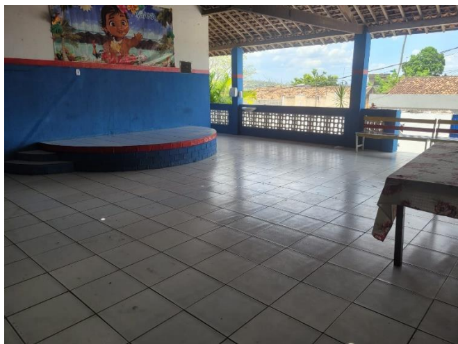
Foto 7: Revestimento cerâmico do pátio executado.
