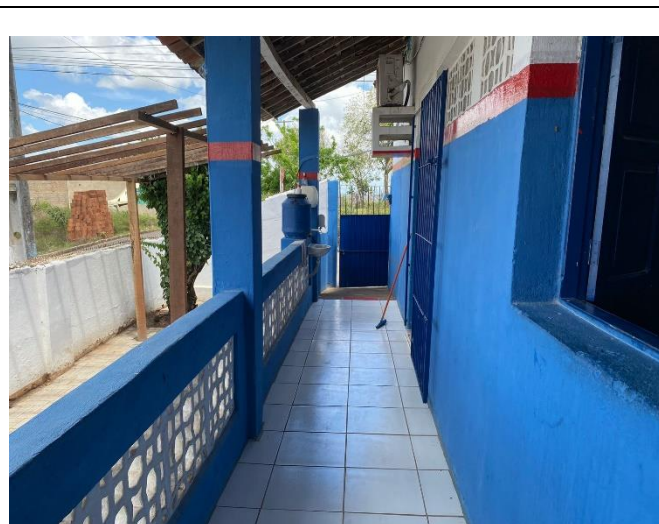
Foto 14: pintura da parede do pátio executada.
