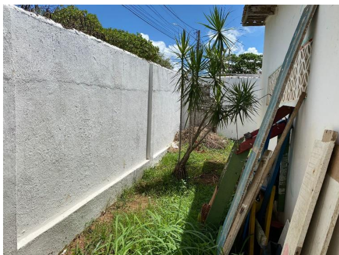
Foto 5: Pintura da parede externa executada.
