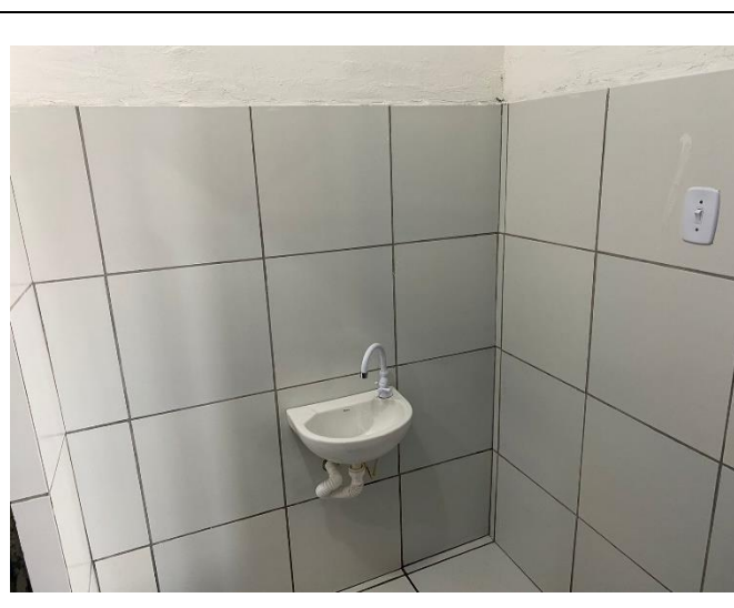
Foto 4: Louça suspensa instalada.
